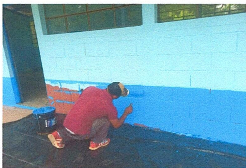
Foto 5: Aplicación de pintura en paredes exteriores.
