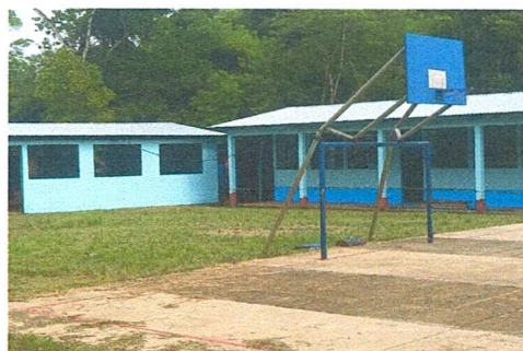
Foto 4: Vista panoramica cubierta instalada.
