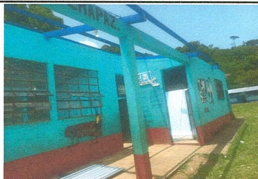
Foto 2: Sustitucion de estructura metalica en mal estado.
