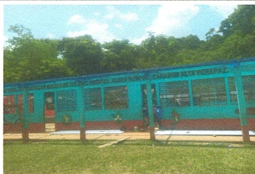
Foto 3: Instalacion de laminas troqueladas.
