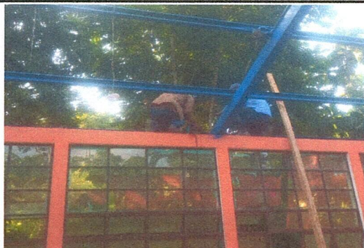
Foto1: Mantenimiento de estructura metalica (lijado)
